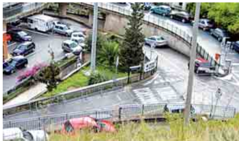
L'AREA DELLA POSTAZIONE DELL'AMBULANZA, IN VIA S. FILOMENA DI TRAPPITELLO [FOTO ROMANO]
